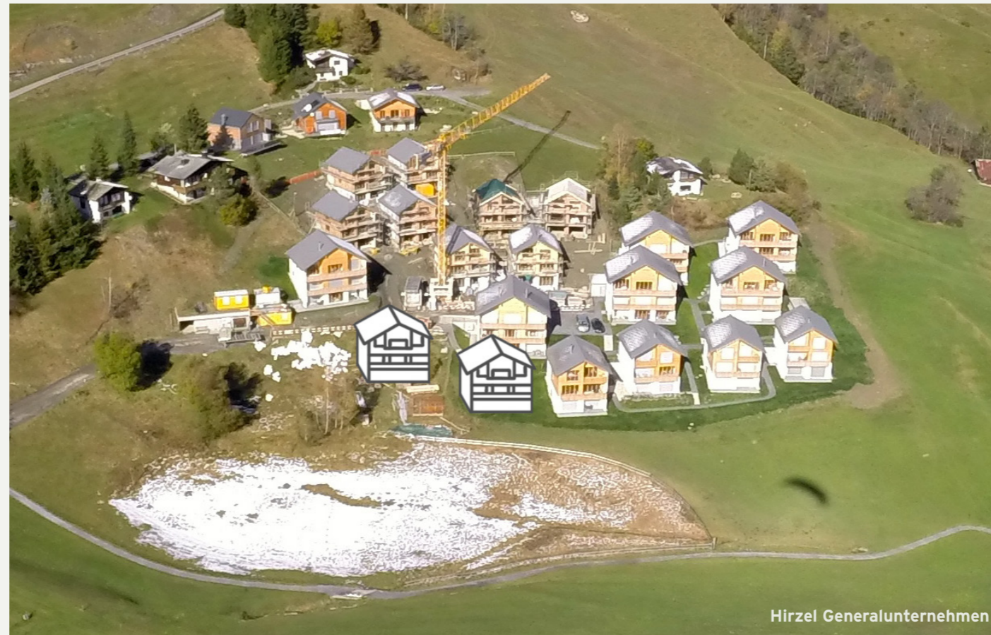
Die Ferienhaussiedlung im Bau. Wie sähe es aus, wären zwei weitere Häuser erstellt worden?
