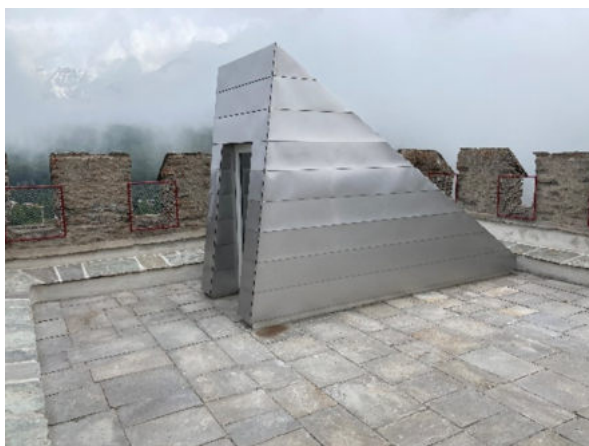
Die Dachterasse des Torre Belvedere nach dem Umbau.
